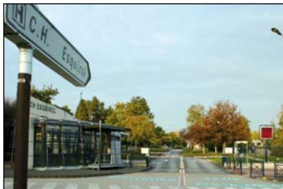
Entrée principale rue du Docteur Marcland
